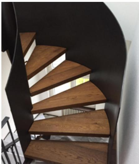
*Ein bestehender Dachboden sollte zu einem neuen Schlafzimmer ausgebaut werden. Dafür fertigte bickel.swiss eine Wendeltreppe aus Stahlblech an, die komplett aus einem Stück gefertigt sein musste, damit keine Schrauben sichtbar sind.*
