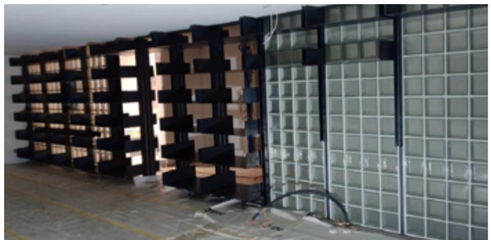
*Bei einem bestehenden Gebäude wurden die Innenwände entfernt und durch ein tragendes Büchergestell ersetzt.*
