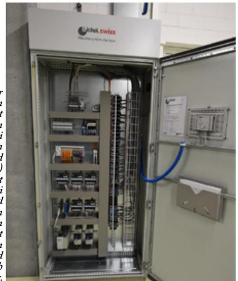
*Mit dieser Steuerung werden insgesamt 14 Abwurf Türen von zwei Abwurfanlagen (Wäsche und Müllabwurf) überwacht sowie zwei Förderbänder und zwei Sackbremsen angesteuert. Ein Touchscreen stellt die aktuellen Meldungen und Vorgänge grafisch dar.*
