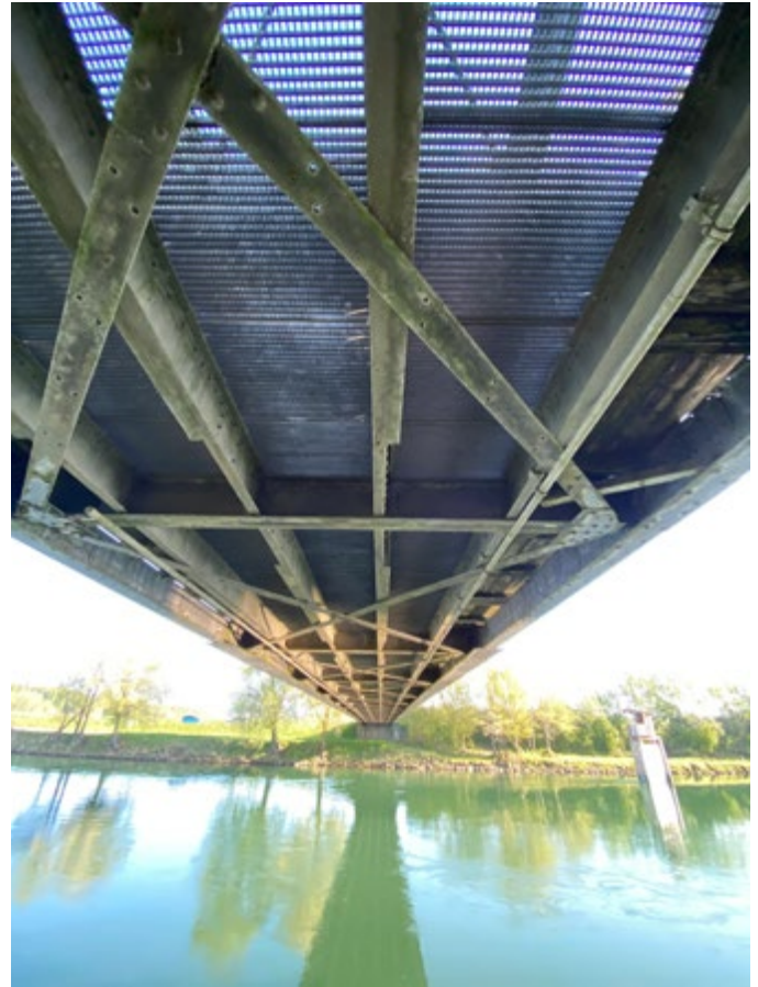
Untersicht der Brücke mit Blick auf das Tragwerk über dem Wasser.
