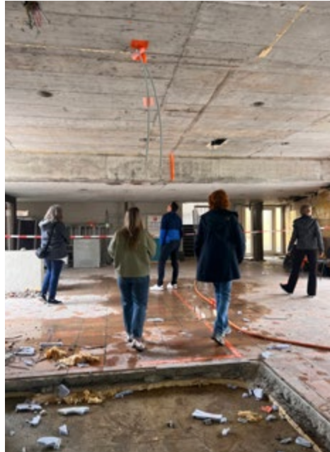
Besichtigung des Baufortschritts durch die Gemeindevertreter
