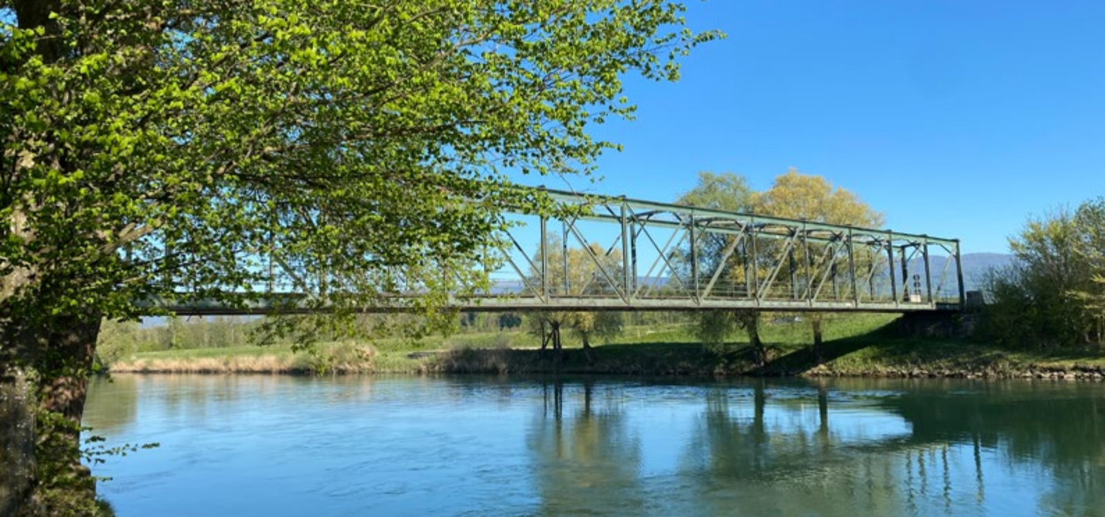
Ansicht der bestehenden Brücke über den Hagneckkanal in Walperswil
