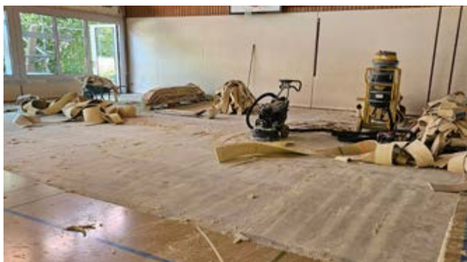
Sanierung des Hallenbodens
