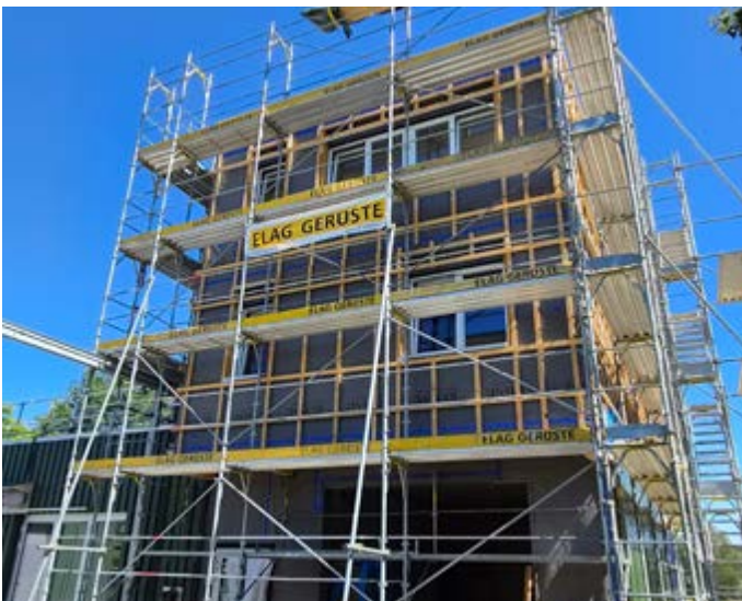
Das neue Betriebsgebäude entsteht auf dem Fundament des alten Gasspeichers
