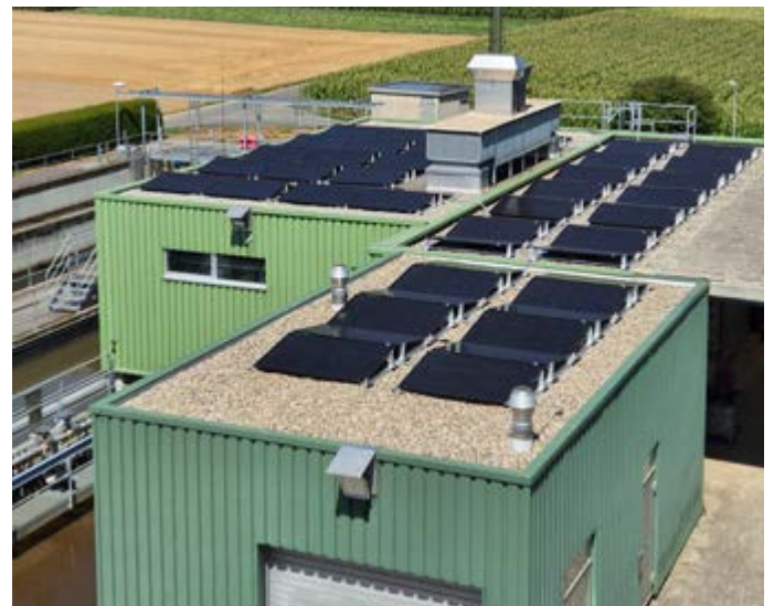
Auch die Dächer der bestehenden Gebäude werden mit Solarpanelen bestückt.
