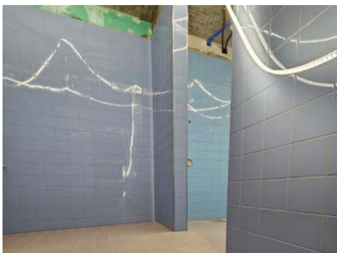
Einblick in die Arbeiten an den Duschräumen
