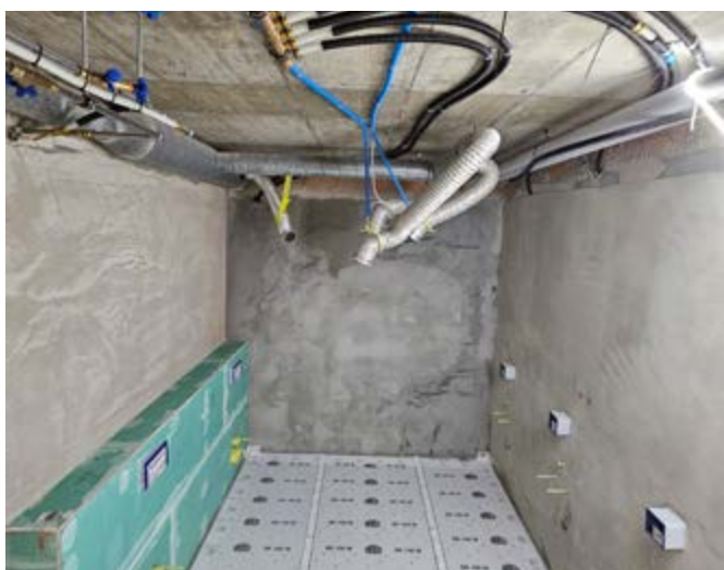
Die Arbeiten am Herren-WC
